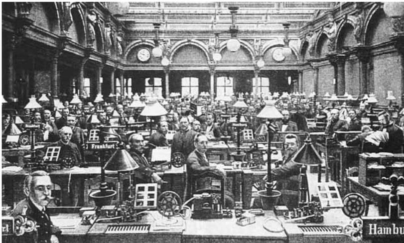
Abbildung 4.16 Saal mit Typendruck-Apparaten des „Haupt-Telegraphenamtes“ zu Berlin um 1900 [2]
