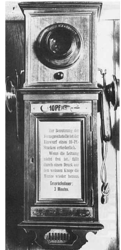
Abbildung 5.8 Einer der ersten Münzfernsprecher, der um 1891 entwickelt wurde [2]
